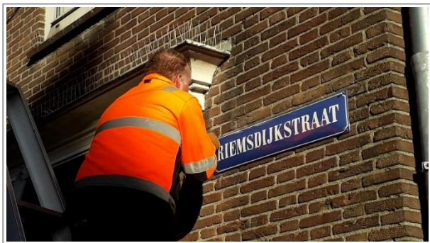
Het plaatsen van een bord in de Riemsdijkstraat
