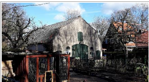
Achterzijde boerderij Dolderstraat 8 in oorspronkelijke staat
